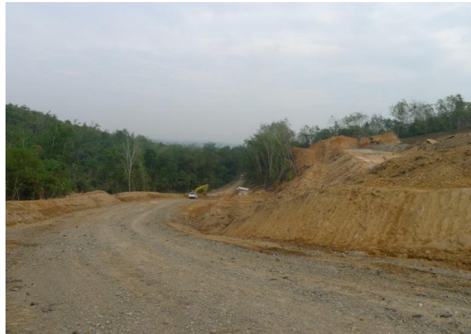
Gambar 8. Parit pada salah satu sisi jalan.
