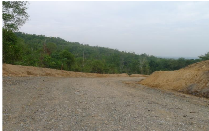
Gambar 7. Kondisi jalan yang telah diberi lapisan perkerasan.
