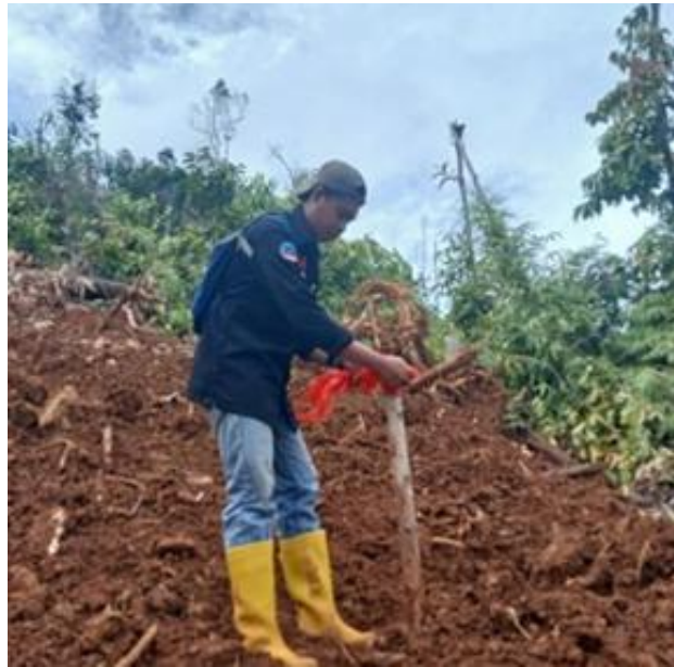
Gambar 2. Penentuan titik lokasi bor berdasarkan drill plan
